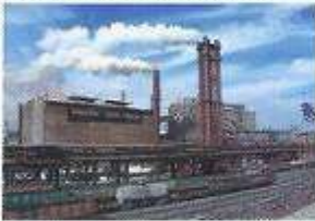
Centrale thermique au charbon
