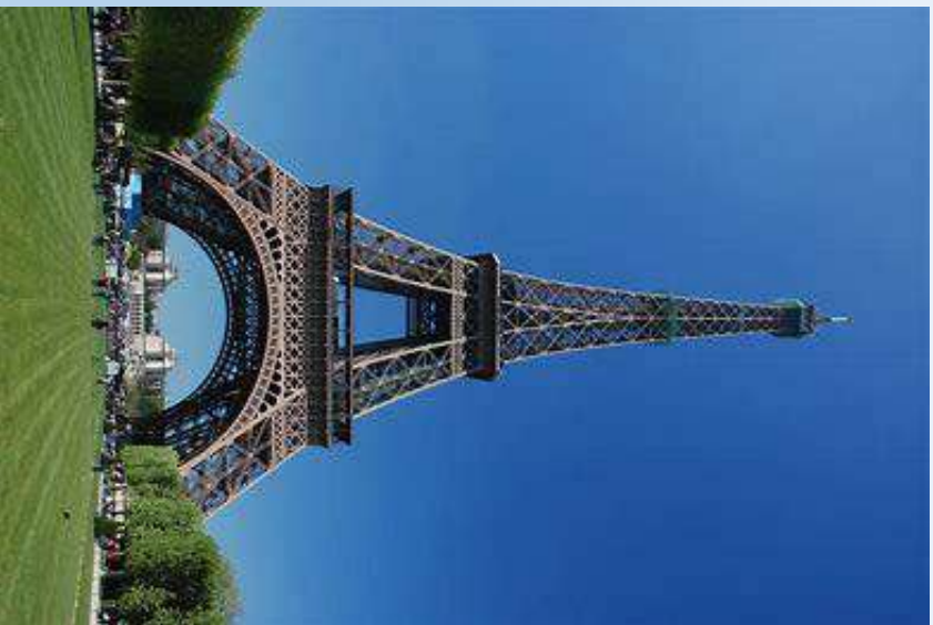
1) La tour Eiffel structure en fer puddlé 1889
