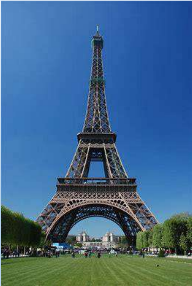
1) La tour Eiffel structure en fer puddlé 1889
